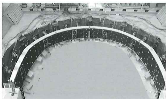
写真-2 実大規模の覆工載荷試験
